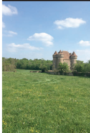
ENTRÉE DE BOURG REMARQUABLE - SARZAY
