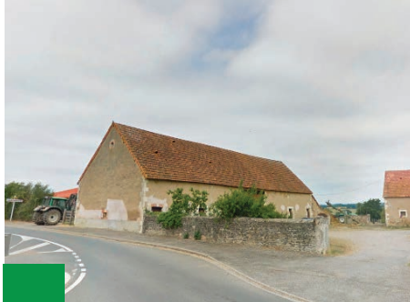
BÂTIMENT AGRICOLE ANCIEN
